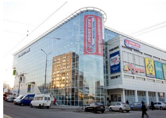
Рис. 6. Торговий центр «Приозерний» по вул. Боброва, 2
