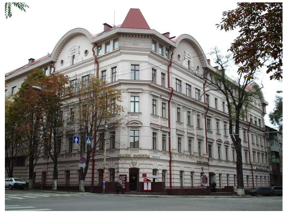
Рис. 3. Житловий комплекс «Первозванівський» по вул. Старокозацькій, 25 (колишня вул. Комсомольська)
