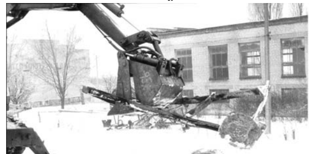
Рис. 9. Багатоцільове обладнання екскаватора: а – схоплення уламків; б – переміщення конструкції
