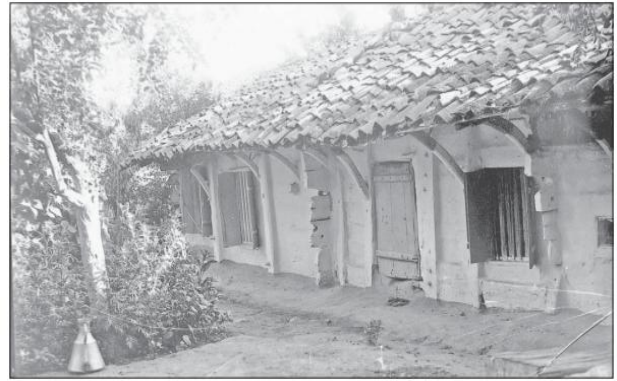
Рис. 10. Коккоз. Будинок, південний фасад. Фото 1929 р. з фондів БІКАМЗ № 276 (959–230) / Fig. 10. Coccosis House, south facade. Photo 1929 from the funds of BIKAMZ № 276 (959–230)
