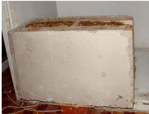
Рис. 4. Загальний вигляд фрагмента стінової конструкції
