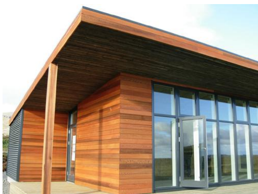
Рис. 4. Загальний вид каркасно-панельного будинку
