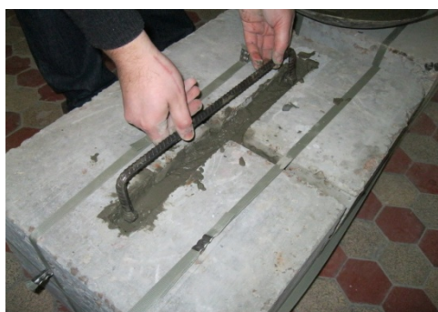
Рис. 5. Размещение арматуры штрабы
