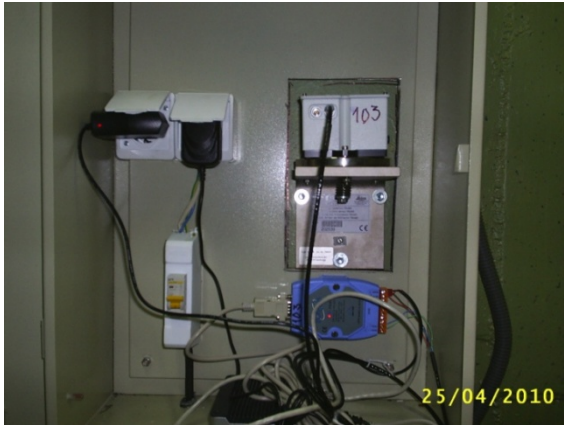
Рис. 3. Расположение первичных преобразователей
