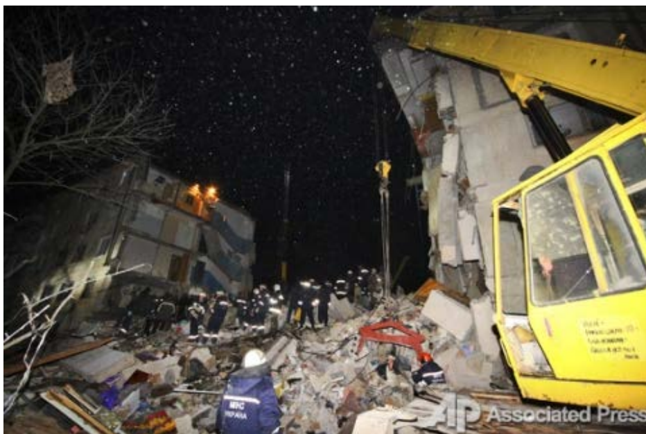
Рис. 3. Розбирання завалу з використанням захвату на крані
