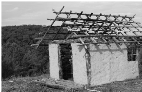
Рис. 2. Дерев'яний каркас покрівлі
