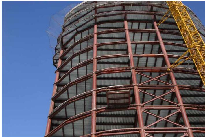
Рис. 1. Пример здания с применением трубобетона
