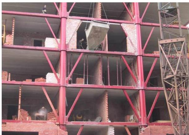
Рис. 14. Возведение АЖК «Днепровский» с использованием трубобетонного каркаса
