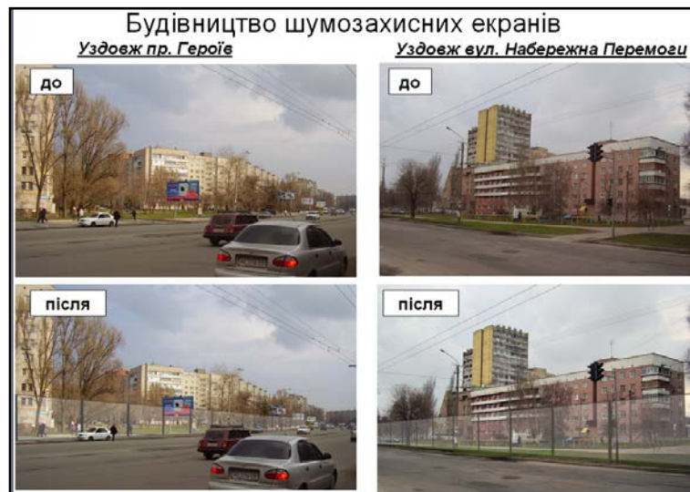
Рис. 2. Розташування рекомендованих шумозахисних екранів для акустичної безпеки при реконструкції спального району «Перемога»
