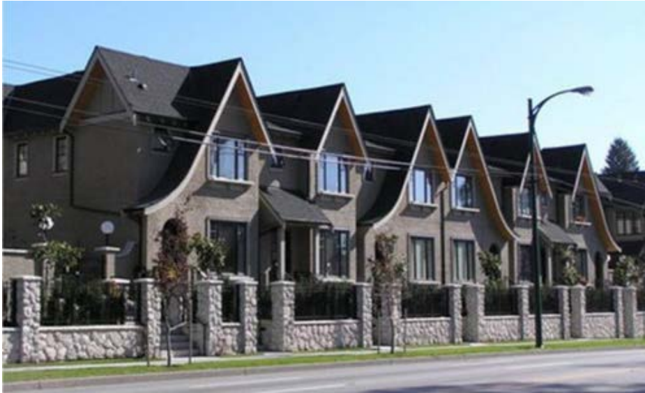
Рис. 12. Загальний вид об'ємно-модульного мотелю
