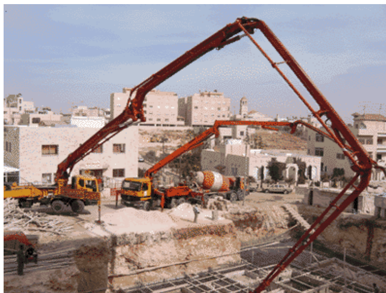
Рис. 6. Применение автобетононасосов для укладки бетонной смеси
