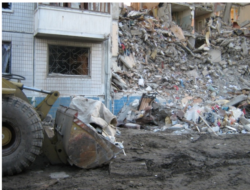
Рис. 1. Використання однокішшового навантажувача для розбирання завалу (м. Дніпропетровськ)
