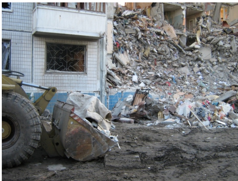
Рис. 1. Використання одноківшового навантажувача для розбирання завалу (м. Дніпропетровськ)
