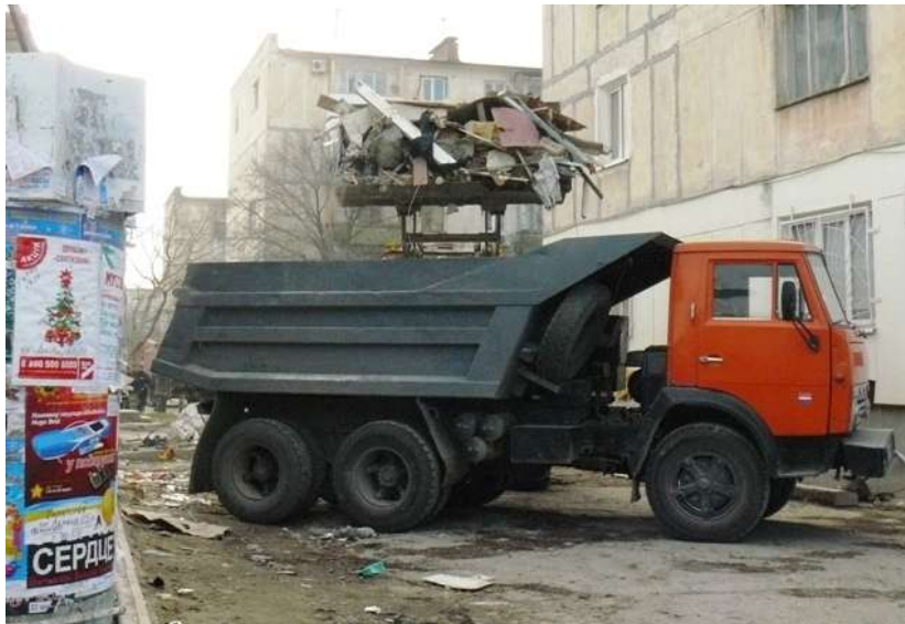
Рис. 2. Завантаження автосамоскида уламками завалу
