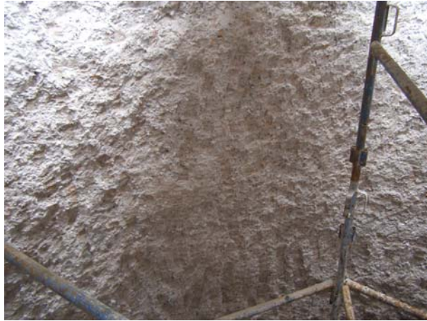
Рис. 3. Повреждения конструкций шахты № 10: а – разрушение железобетонной рубашки; б – коррозионный износ лестницы
