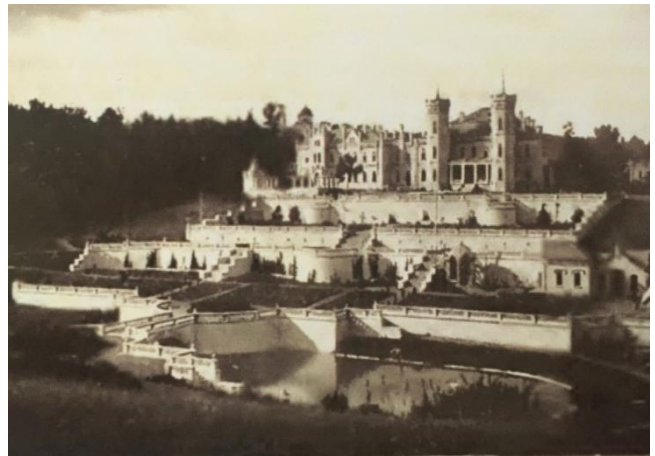
Рис 2. Загальний вигляд палацу і терас на початку XX століття / Fig. 2. General view of the Palace and terraces in the early XX century
