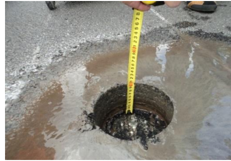
Рис. 1. Установка для отбора проб КП 151-3-02 и высверленный проб в дорожном покрытии
