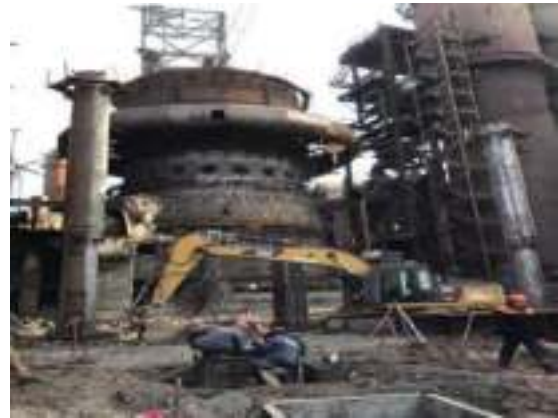
Рис. 7. Застосування кожухів зі сталі марки 10Г2ФБ у доменній печі № 3, Запорізьсталь
