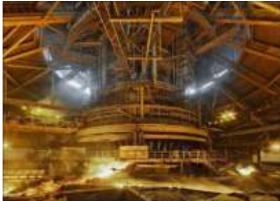
Рис. 5. Використання сталі з нітрідним зміцненням типу 16Г2АФ у будівництві бункерної естакади ДП-9 «Криворізьсталь» (нині – ПАТ «АРСЕЛОРМІТТАЛ КРИВИЙ РІГ»)
