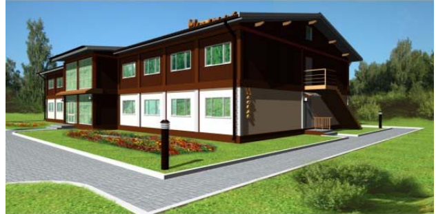
Рис. 1. Швидкозведений модульний готель на 33 номери
