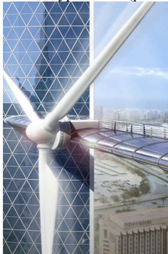
Рис. 3. Одна из турбин на горизонтальной опоре ВТЦ в Бахрейне
