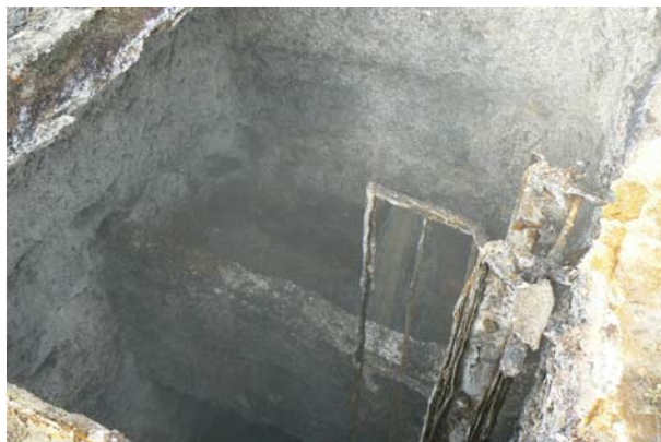
Рис. 4. Повреждения конструкций шахты № 3: а – разрушение железобетонной крепи; б – коррозионный износ плиты
