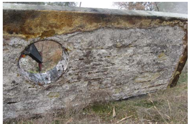
Рис. 4. Повреждения конструкций шахты № 3: а – разрушение железобетонной крепи; б – коррозионный износ плиты
